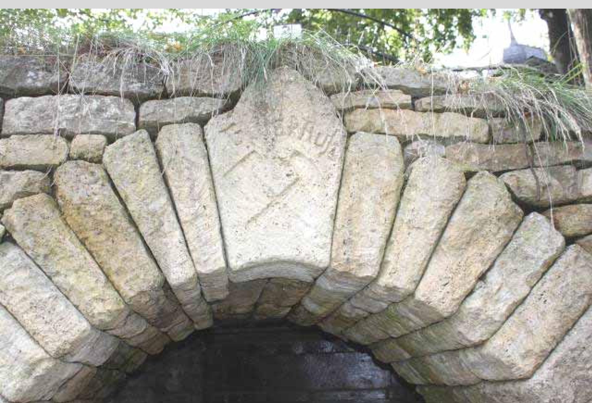
Am Besucherbergwerk Kamsdorf
